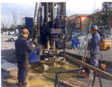
Una perforazione per rilevare la presenza di cromo esavalente (Foto by Archivio2)
